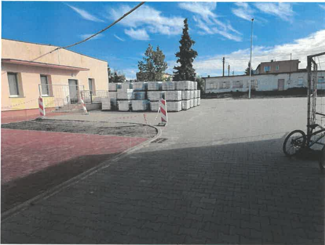
Zdjęcia przedstawiają remontowany teren mający pełnić funkcję placu manewrowo apelowego.
