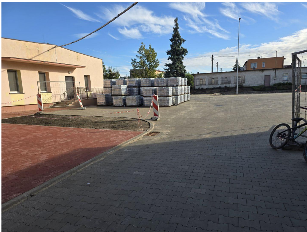
Zdjęcia przedstawiają remontowany teren mający pełnić funkcje placu manewrowo apelowego.
