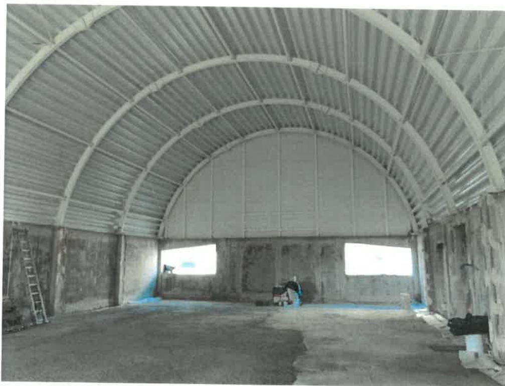
Hala sportowa przy ZS im. W. Łokietka w Lubaszczu - w trakcie budowy
