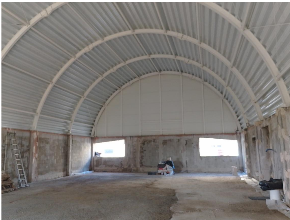
Hala sportowa przy ZS im. W. Łokietka w Lubaszczu - w trakcie budowy
