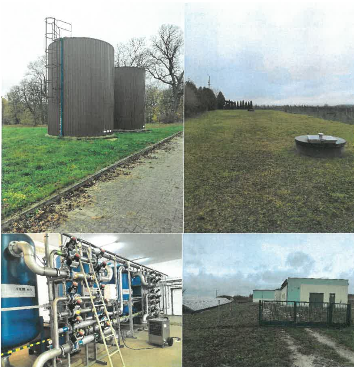
Widok stacji uzdatniania wody, zbiorników wyrównawczych oraz studni
