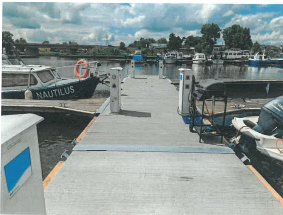
Zdjęcie nr 2. Pomost po remoncie.
